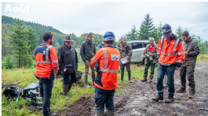
Lancement des travaux sur le Grand Fouchot
